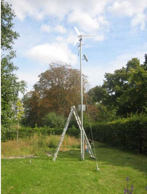
Das fertige Windrad wartet auf den Wind. Deutlich ist der Schalt- und Akkukasten zu erkennen. Er ist in einer Höhe von ca. 2,5m am Mast befestigt, um ihn vor Unbefugten auf dem Schulgelände zu sichern.
