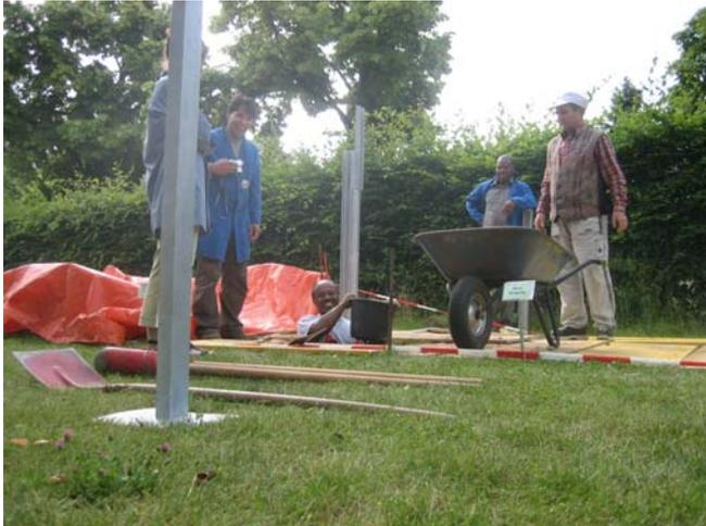
Gut zu erkennen sind die Fundamentfüße mit ihren Grundplatten, die in die Erde eingegraben werden.
