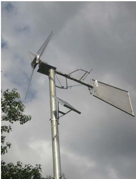
Besonders im Herbst, Winter und im Frühjahr, wenn die solare Einstrahlung gering ist, stellen Kleinwindräder eine ideale energetische Ergänzung von photovoltaischen Inselanlagen dar. Die Kombination von Photovoltaik und Windenergie eignet sich ausgezeichnet für dezentrale Energiesysteme der 3. Welt.
