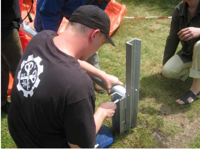
Windmasten von Kleinwindrädern sollten stets kippbar konstruiert werden. Das erleichtert die spätere Wartung des Windrades erheblich.
