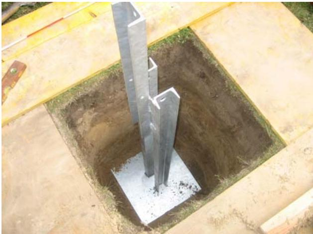
Um eine spätere Umsetzung des Windrades zu erleichtern, wurde auf den Einsatz von Beton beim Fundament verzichtet. Der verzinkte Mastfuß ist ca. 1,5m in den Boden eingegraben. Anschließend wurde der Sandboden oberhalb der Grundplatte gut verdichtet. Zu achten ist darauf, dass der Mastfuß beim Zuschütten und Verdichten der Erde absolut senkrecht fixiert bleibt. Bei den Halterungen für die Abspannseile wurde nach der gleichen Weise verfahren.
